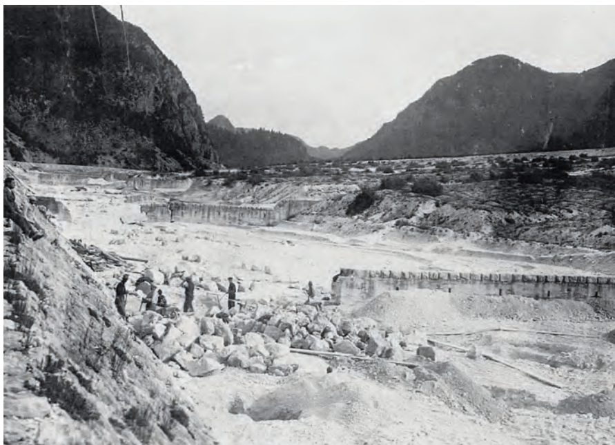
Lavori di costruzione delle briglie lungo l'argine
