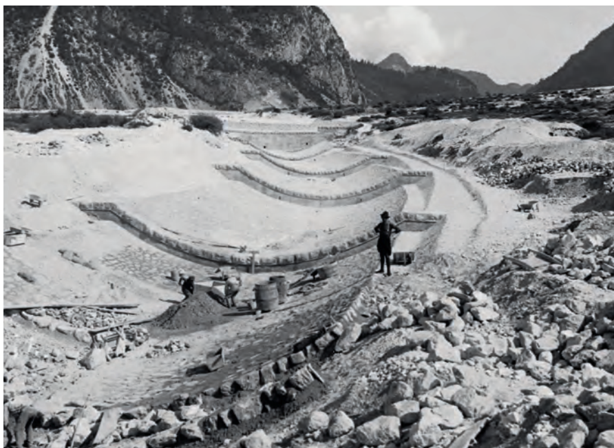
I lavori di prolungamento e correzione della "rosta"
