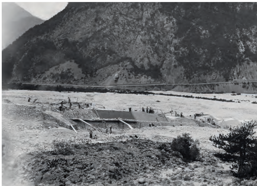
Lavori di costruzione dei muri di contenimento del Rio Cite
